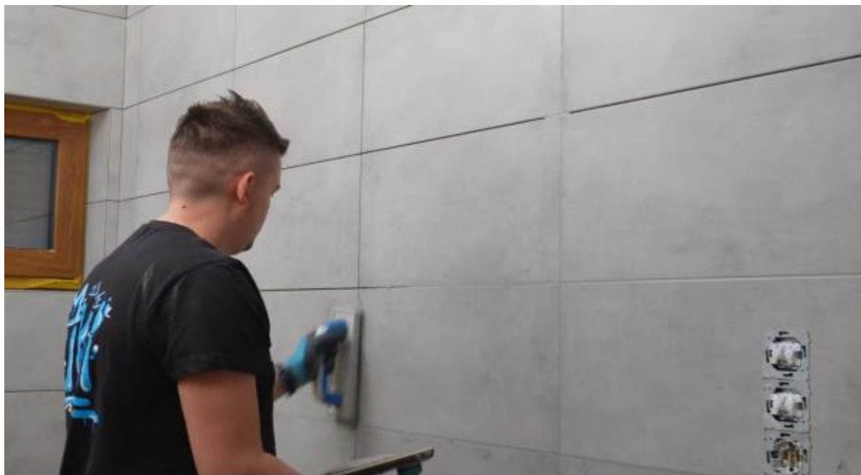
Rys. 26. Kadr z filmu przedstawiającego nakładanie fugi CE 60
