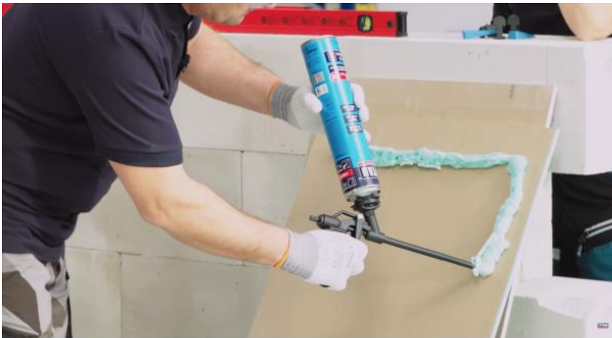
Rys. 35. Kadr z filmu przedstawiający montaż płyt gipsowo-kartonowych z wykorzystaniem pianokleju
