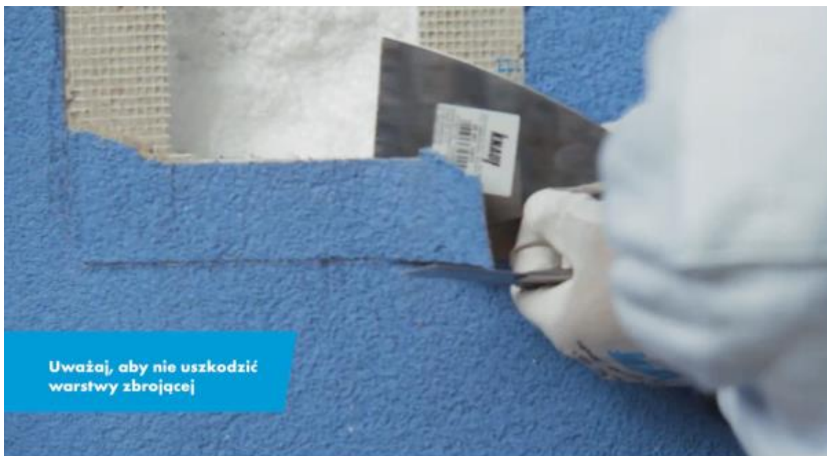
Rys. 10. Kadr z filmu przedstawiającego proces naprawy dziury w elewacji
