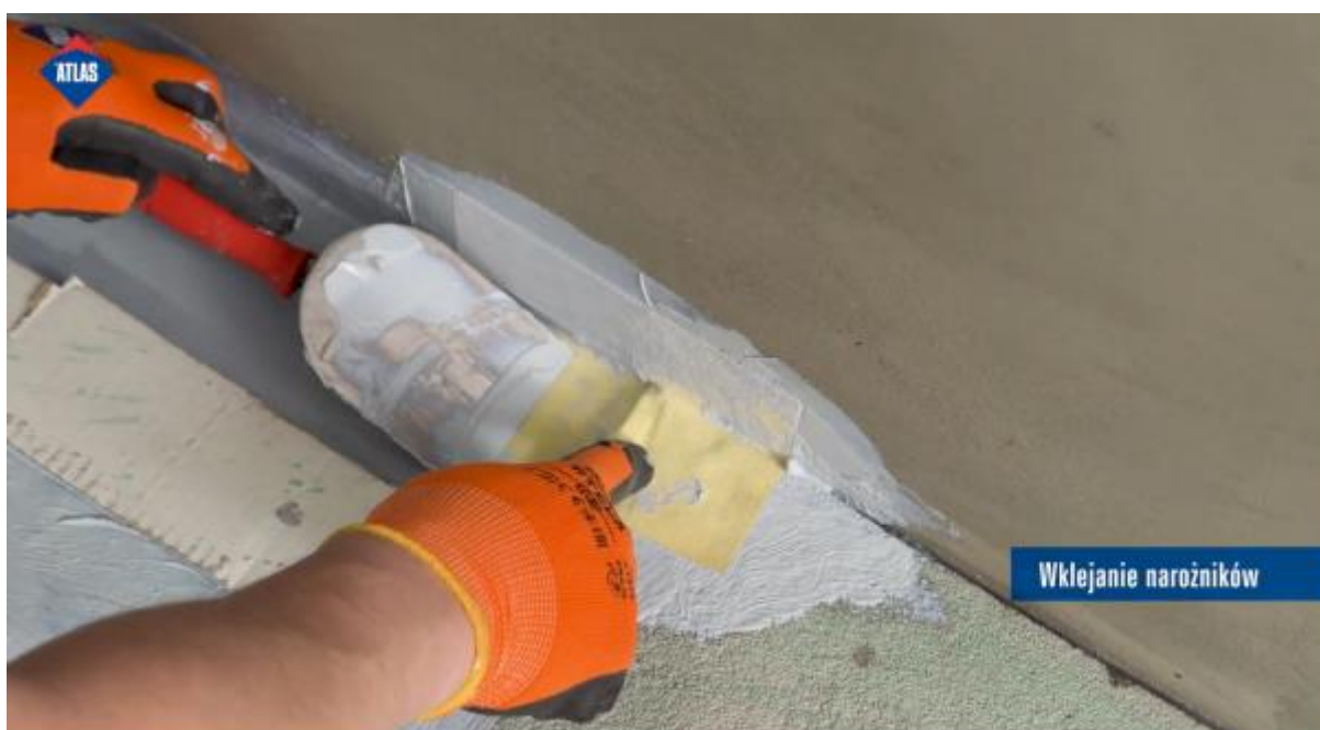
Rys. 18. Kadr z filmu przedstawiającego wykonanie hydroizolacji w łazience
