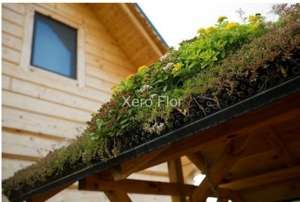
Rys. 42. Przykład zielonego dachu
