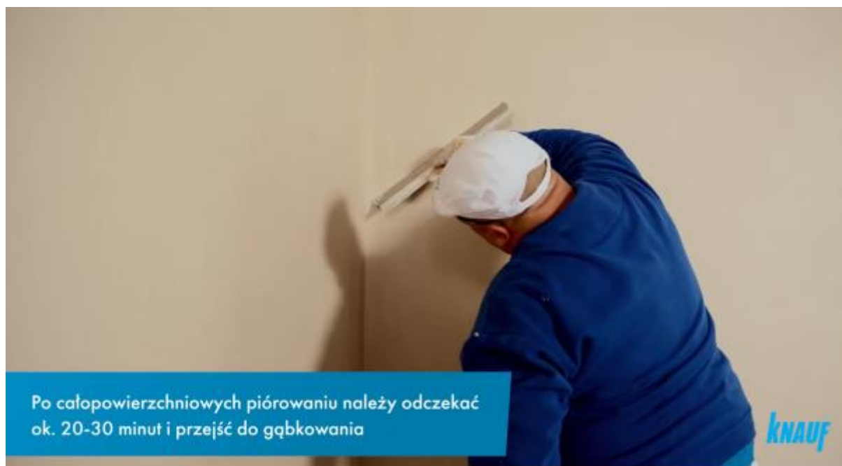
Rys. 4. Kadr z filmu przedstawiającego wygładzanie tynku
