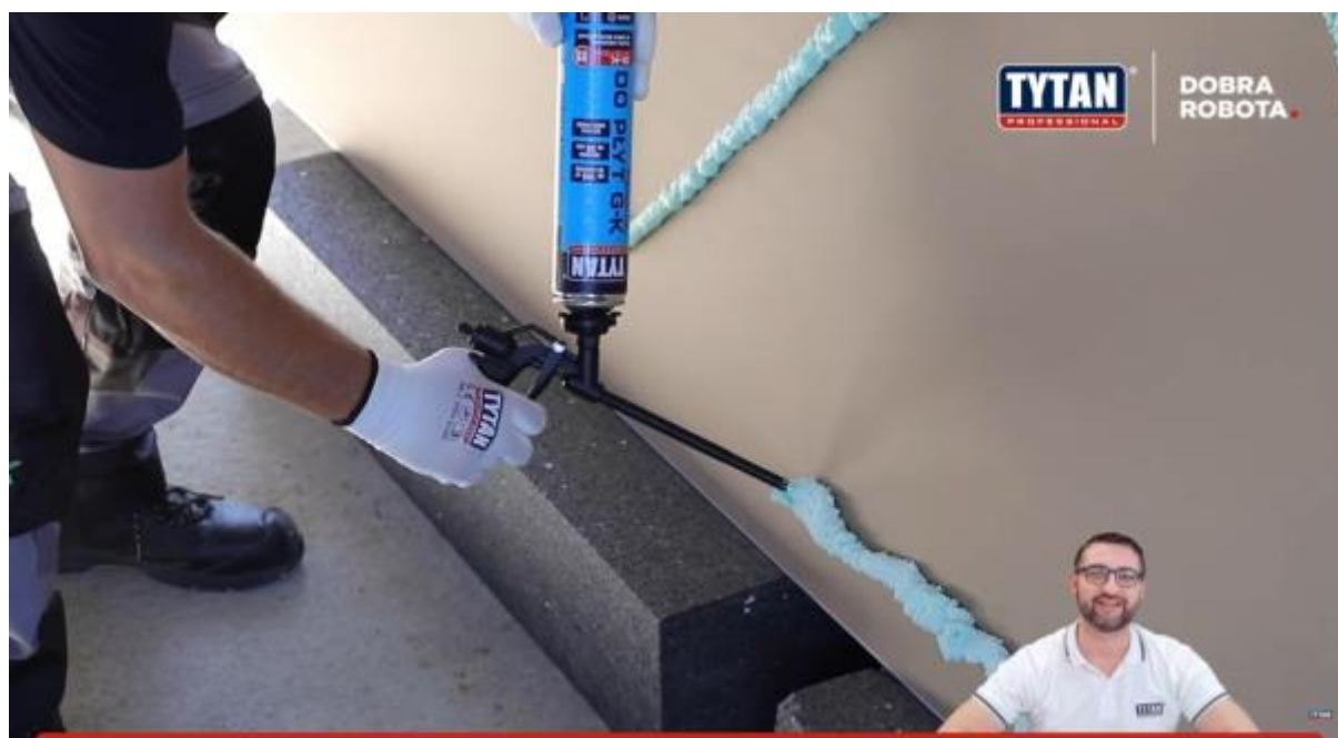
Rys. 37. Kadr z filmu przedstawiający zagadnienia stosowania pianokleju w montażu płyt gipsowo-kartonowych
