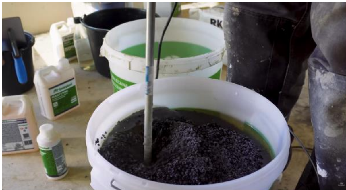
Rys. 39. Kadr z filmu przedstawiający proces wykonywania kamiennego dywanu na balkonie firmy Greinplast
