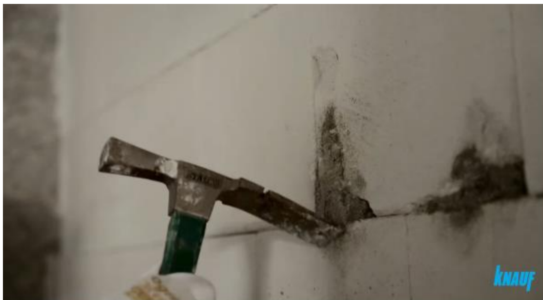
Rys. 1. Kadr z filmu przedstawiającego przygotowanie i gruntowanie podłoża
