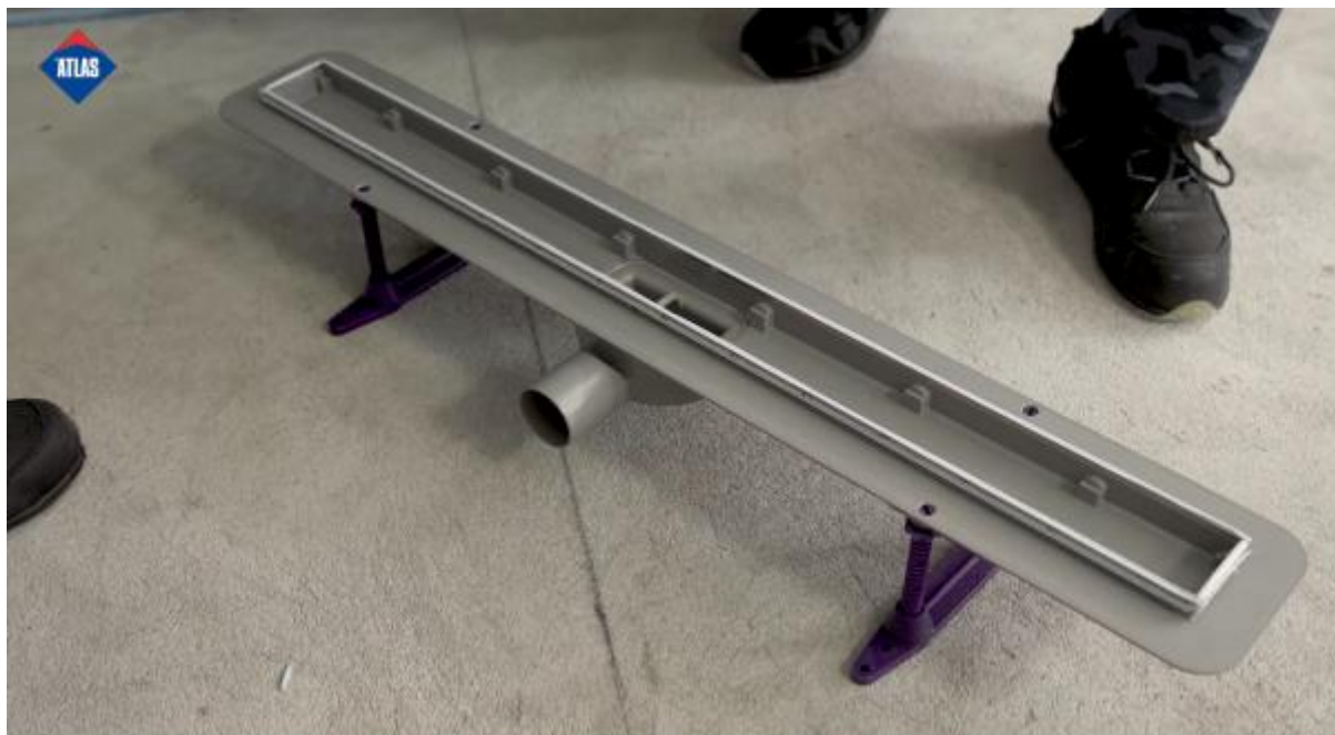
Rys. 19. Kadr z filmu przedstawiającego wykonanie odpływu liniowego w łazience
