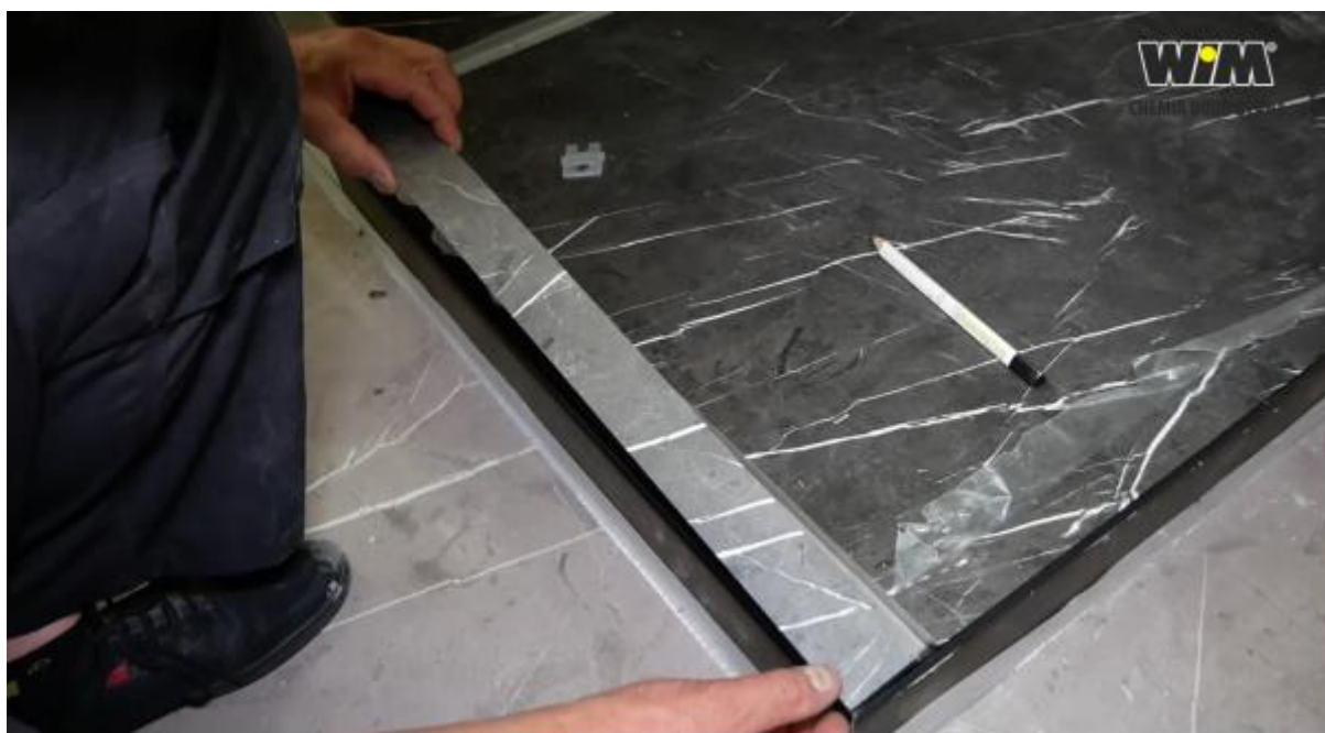
Rys. 40. Kadr z filmu przedstawiający przeprowadzenie metamorfozy łazienki z wykorzystaniem WIM Platte System oraz płyt ROCKO Kronospan
