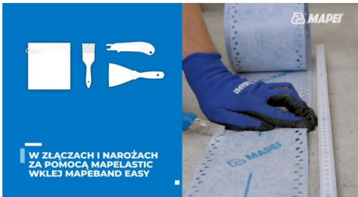
Rys. 23. Kadr z filmu przedstawiającego wykonywanie hydroizolacji na tarasach i balkonach
