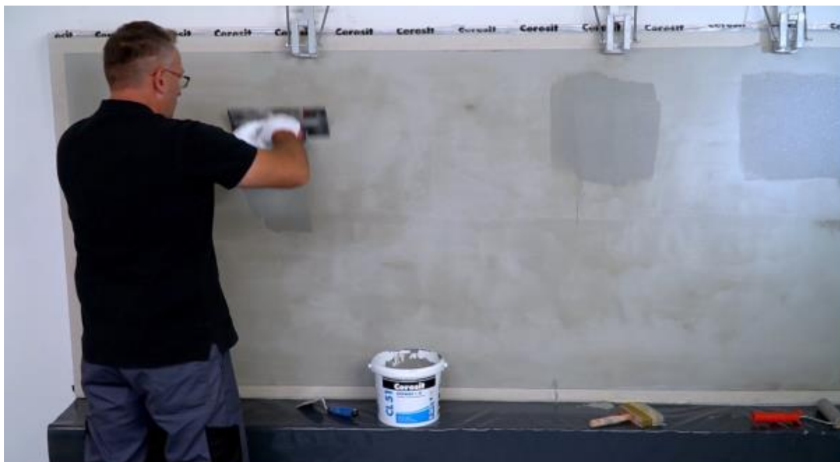
Rys. 30. Kadr z filmu przedstawiający wykonywanie izolacji w pomieszczeniach mokrych
