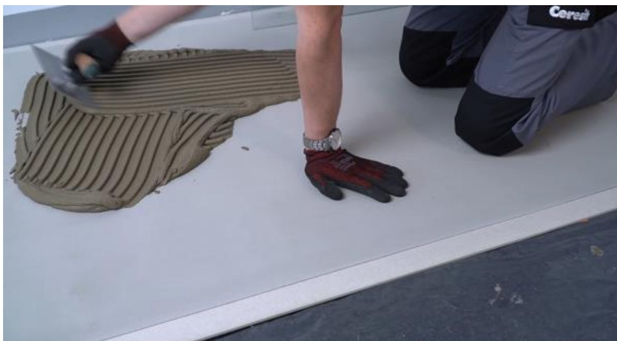
Rys. 32. Kadr z filmu przedstawiający klejenie płytek wielkoformatowych
