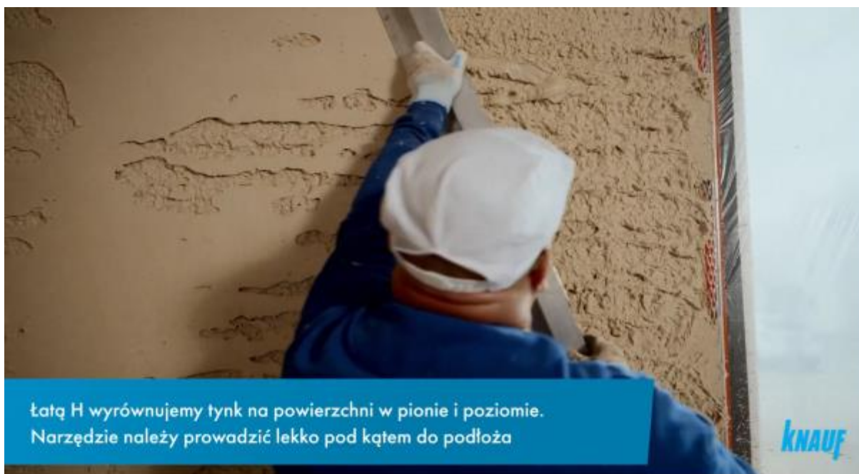
Rys. 3. Kadr z filmu przedstawiającego narzut i obróbkę tynku gipsowego
