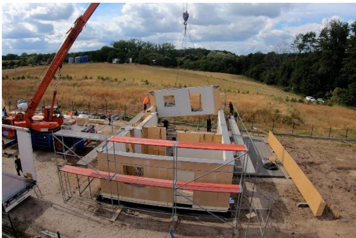
Rys. 46. Budowa budynku z prefabrykatów
