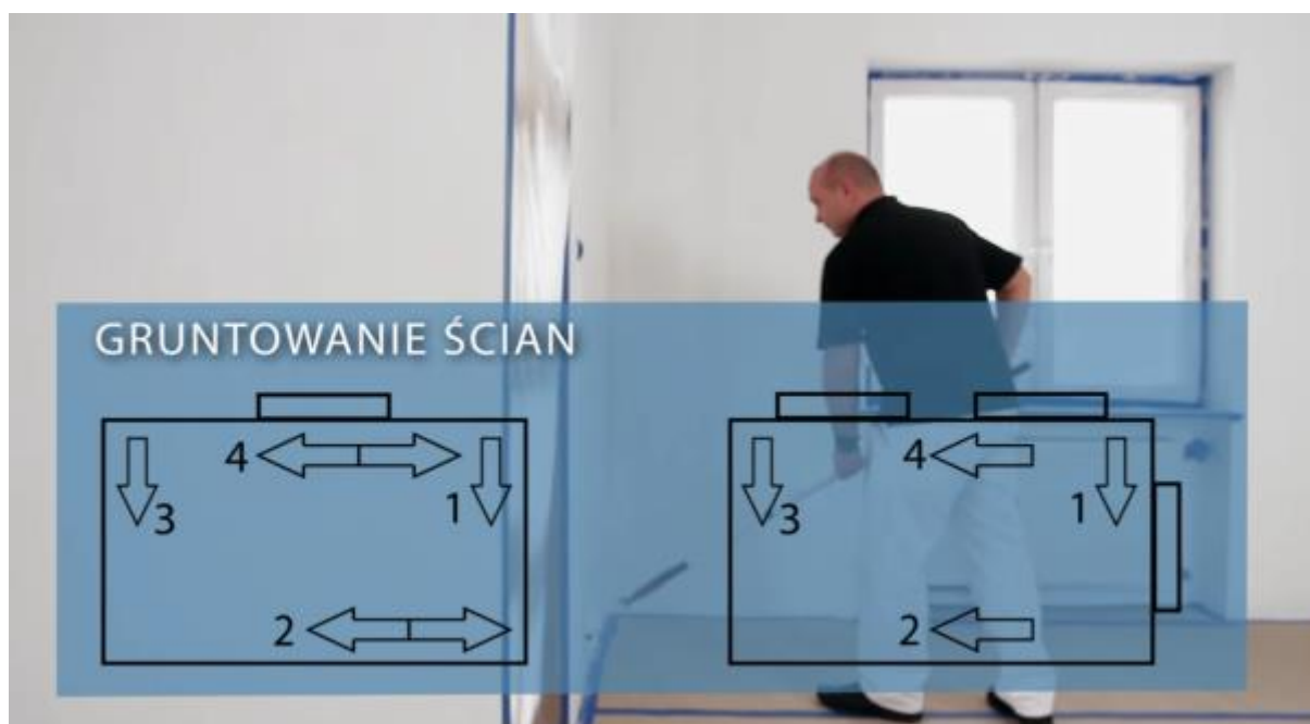
Rys. 41. Kadr z filmu przedstawiający etapy malowania ścian i sufitów
