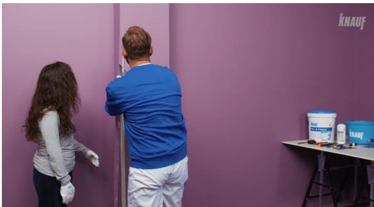
Rys. 8. Kadr z filmu przedstawiającego proces naprawy zniszczonego narożnika ściany
