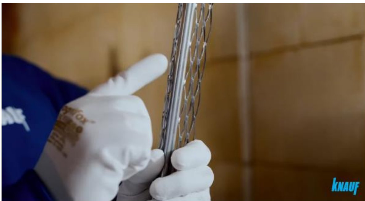
Rys. 2. Kadr z filmu przedstawiającego montaż narożników tynkarskich
