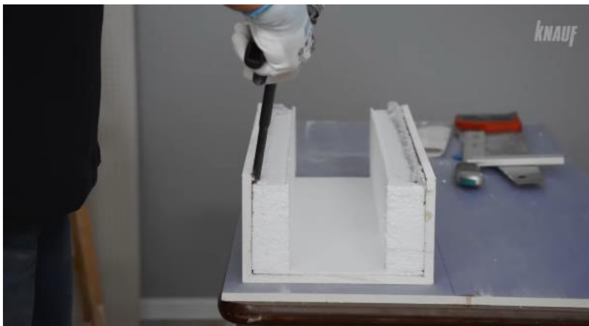
Rys. 16. Kadr z filmu przedstawiającego ukrycie rury za pomocą gotowej maskownicy gipsowo-kartonowej
