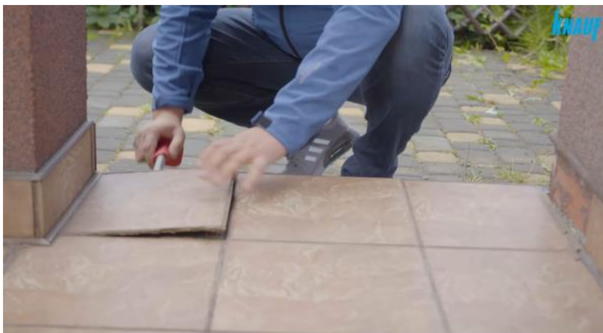
Rys. 17. Kadr z filmu przedstawiającego naprawę zniszczonego tarasu
