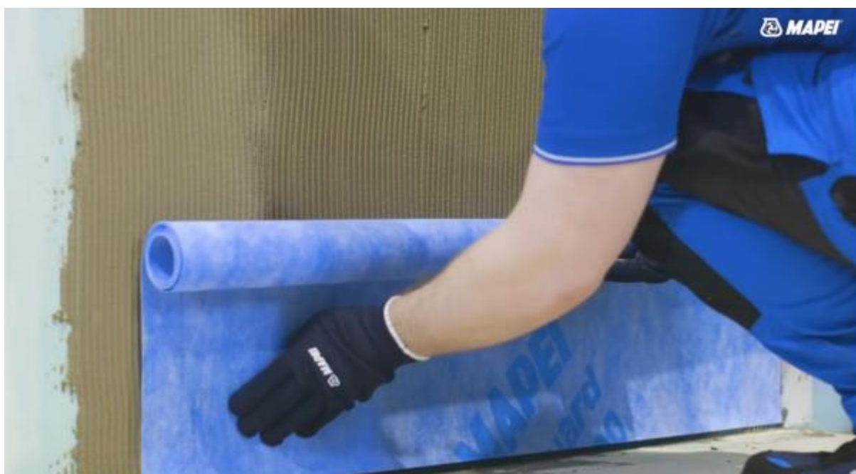
Rys. 24. Kadr z filmu przedstawiającego wykonanie izolacji przeciwwodnej
