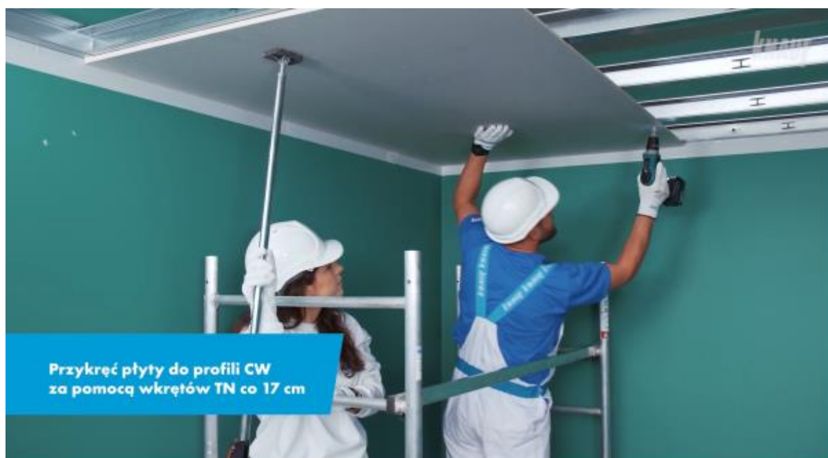
Rys. 14. Kadr z filmu przedstawiającego wykonanie sufitu przęsłowego
